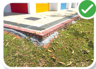
Sealed crevices Celahan ditutup secara sempurna
